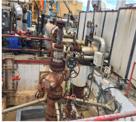
Le premier puits de forage Bouillante 1 (400m de profondeur, fluide à 245°C)
