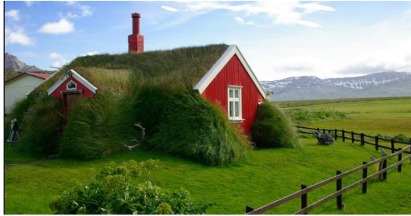
Toit recouvert d'herbe pour isoler du froid
