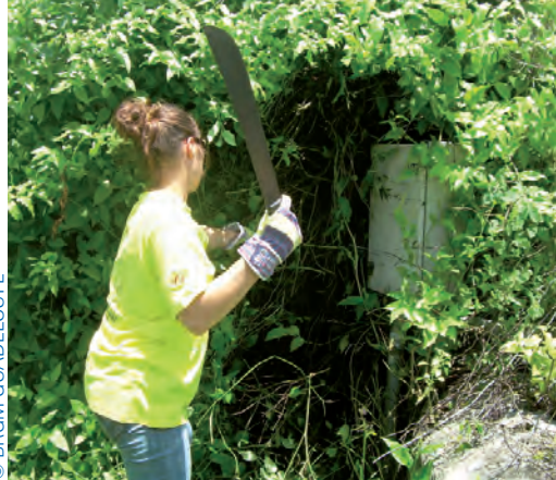
À Girard (Petit-Canal), la nature reprend ses droits et ensevelit complètement cette station. Les hydrogéologues doivent alors savoir manier le sabre !
